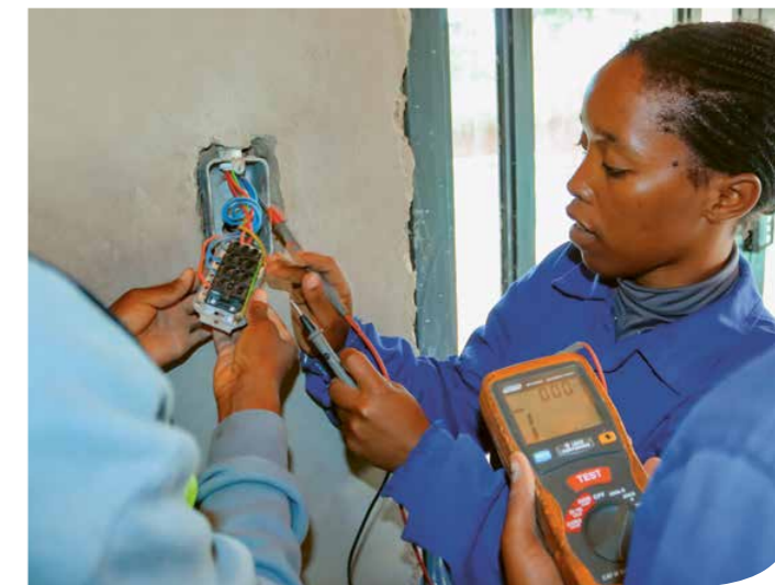
Bild: Violet testet nach der Installation eine Steckdose.
